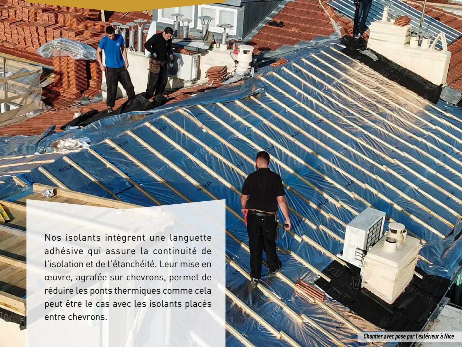
Nos isolants intègrent une languette adhésive qui assure la continuité de l'isolation et de l'étanchéité. Leur mise en œuvre, agrafée sur chevrons, permet de réduire les ponts thermiques comme cela peut être le cas avec les isolants placés entre chevrons.
